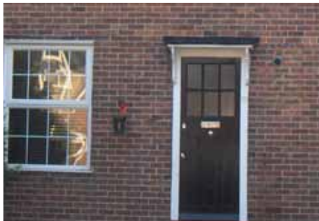
Original door detail
