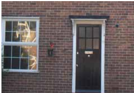
Original door detail
